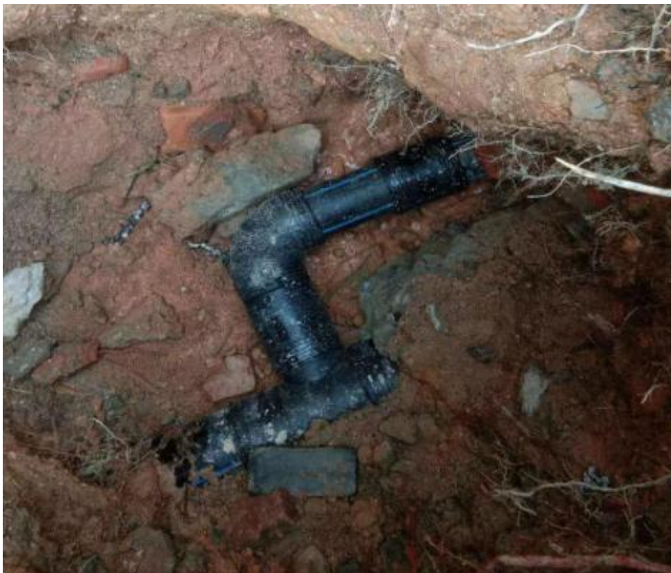
小区庭院埋地燃气管道的管件连接处漏气
